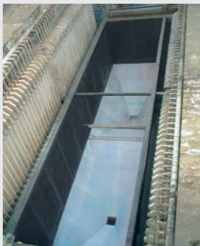
Защитная облицовка материалом РЕМАФЛОН
